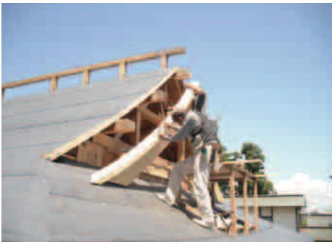
分厚い破風板の取付け(平成24年6月)
